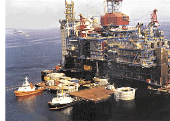
**Causa:** Utilizzo incauto del codice elementi finiti NASTRAN nella fase di progettazione (modello elastico lineare della tricella) in cui gli sforzi di taglio sono stati sottostimati del 47%.
